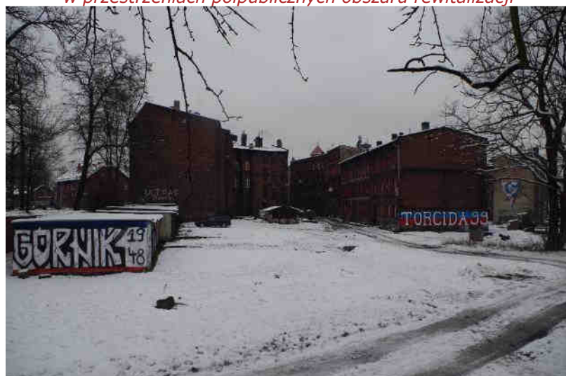
Zdjęcie 4. Zaniedbanie i brak infrastruktury do wypoczynku i integracji mieszkańców w przestrzeniach półpublicznych obszaru rewitalizacji
